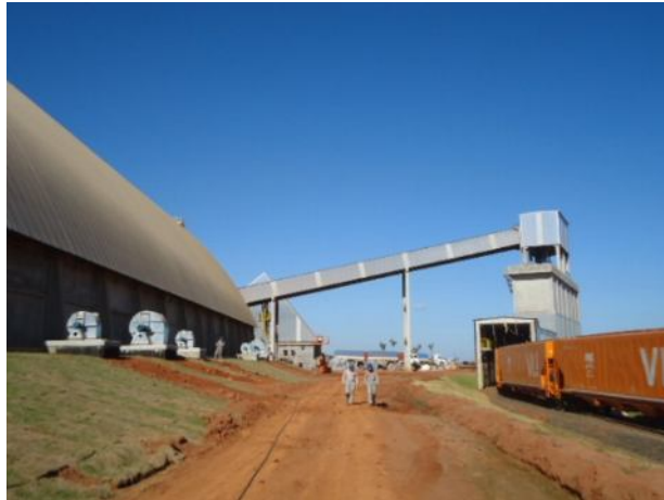
Figura 9 – Área de carregamento ferroviário
